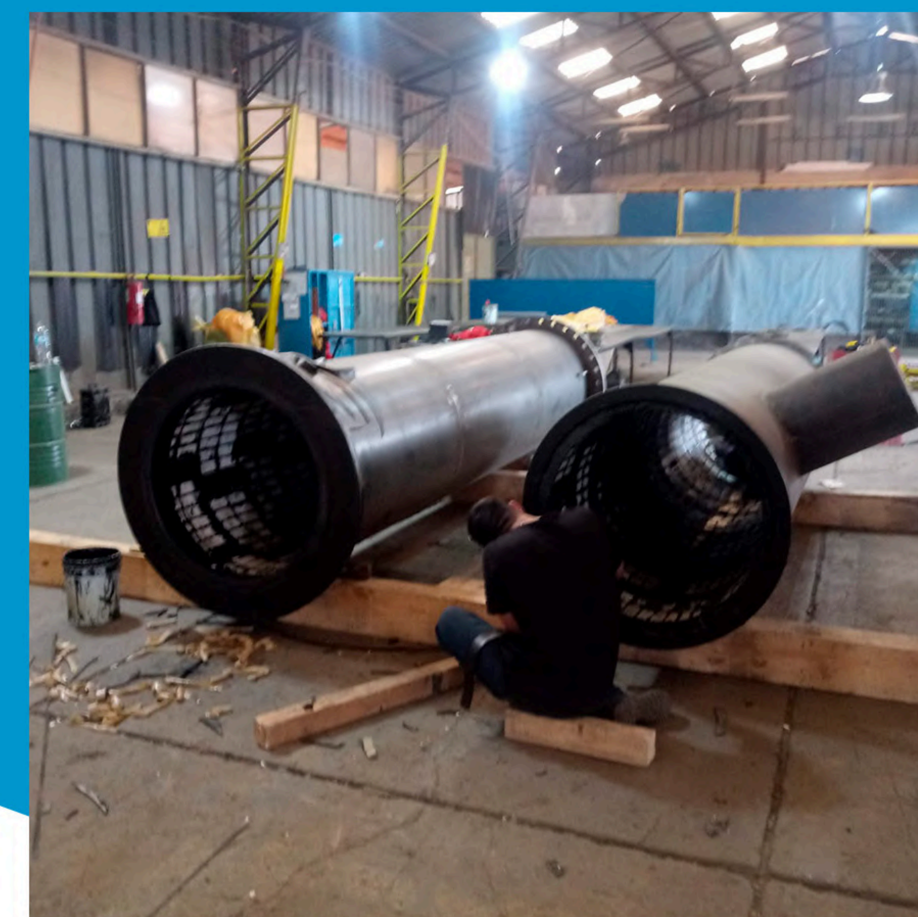
REVESTIMIENTO DE CAÑERIA EN PROCESO
